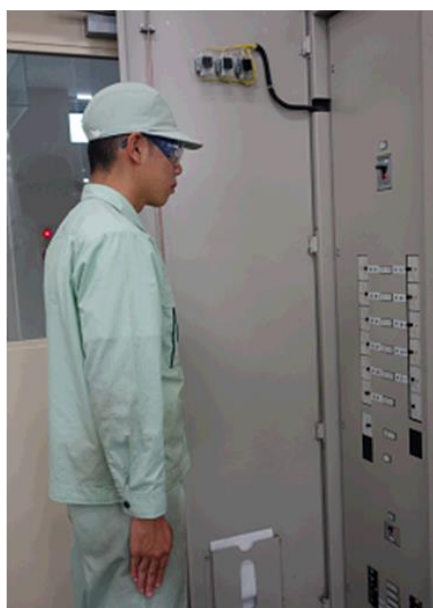
(1) 電源投入したスイッチを見る
