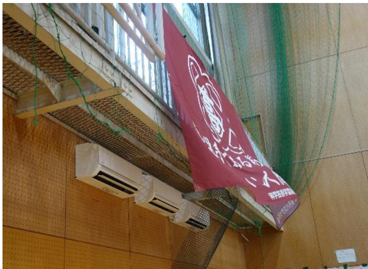
エアコン 12台設置
