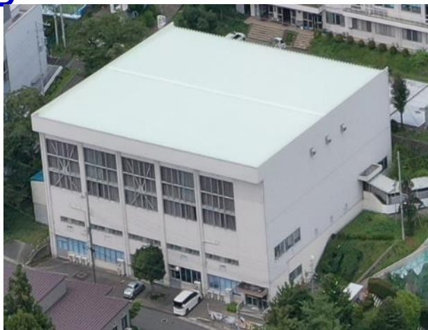
屋根に遮熱塗装
