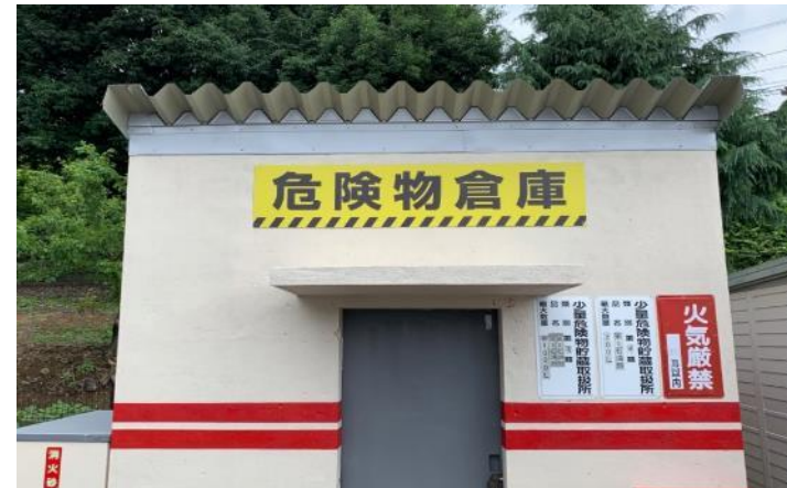
危険物倉庫看板設置
